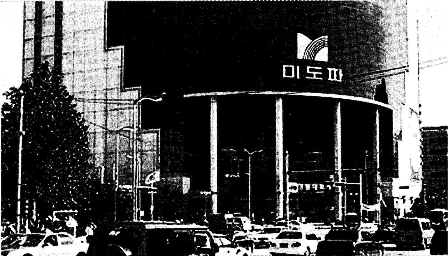
지난해 연말 크리스마스 이브인 12월 24일 공사를 완료한 미도파백화점 상계점은 에너지절감률이 60%로 나타나 화인테크 뿐만 아니라 백화점 측에서도 크게 기대하고 있다. 고효율 조명기기의 교체와 인버터 설치공사에 7억4천만원의 투자비가 소요되었고 이는 48개월에 걸쳐 회수될 예정이다.
