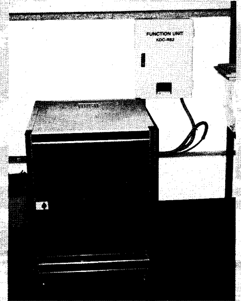
팩키지 에어컨 원격제어시스템은 피크전력이 될 때 강제적으로 실외기의 작동을 중지시키는 제어방식으로 주변전실에 무선송신 콘트롤러(사진 오른쪽)를 설치하고 각 건물별로 에어컨 실외기에 원격수신 단말장치수신장치(사진 왼쪽)를 연결해 Demand Controller가 작동할 때 자동으로 미리 정해놓은 그룹별로 순차적으로 제어된다.
