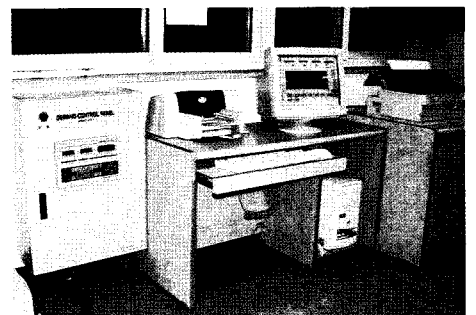
감시반과 최대수요전력제어기(Demand Controller)가 설치된 주변전실 내부모습
