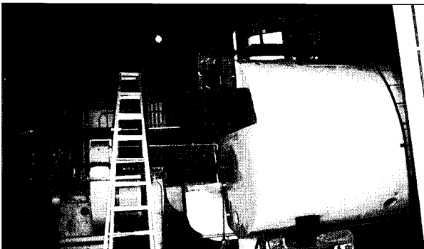
보일러에 설치한 75,000kcal/h 용량의 폐열회수기는 난방과 급탕을 동시에 사용가능한 시스템으로 적용하여 연간 135,424Nm 3 의 연료절감 효과가 예상되고 있다.
