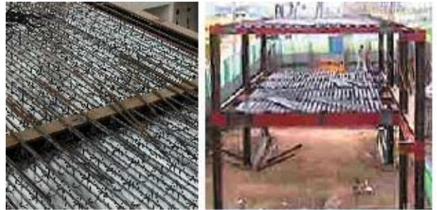
그림 14. 데크 플레이트 설치
