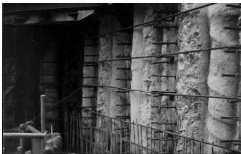
지하 H-pile에 Stud가 접합된 사진
