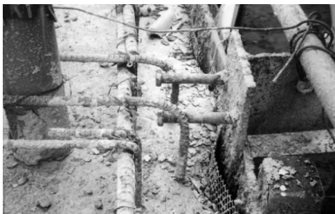
H-pile 상단의 Stud 접합사진
