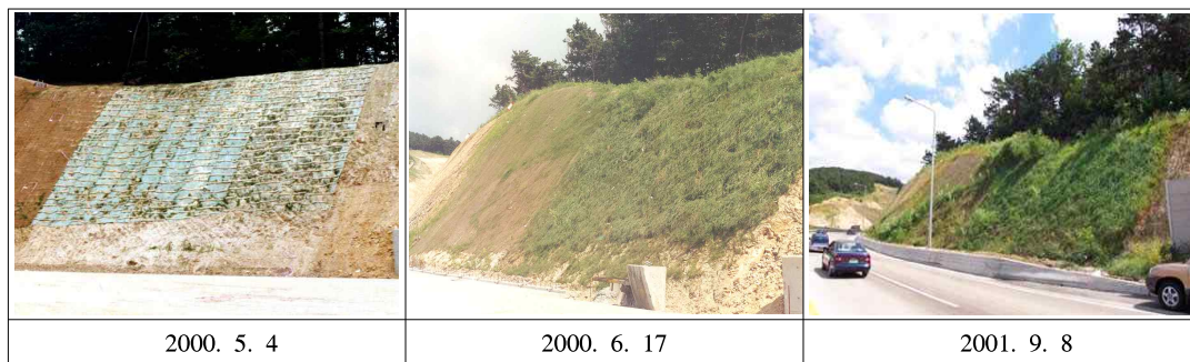
사진 2. 복수원 실험시공 현장 사진
