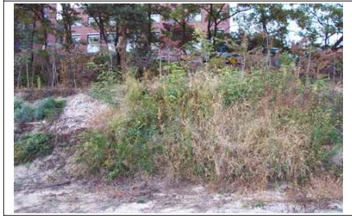
2001. 10. 20 시공 후 100일경
