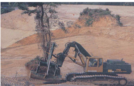
사진 7. 특수장비를 이용한 교목 굴취·운반
