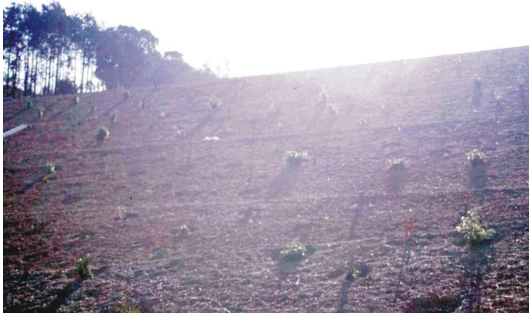
사진 17. 근주 이식공법을 시공한 성토비탈면 상세
