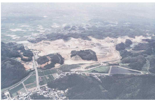
사진 4. 신 캠퍼스 제1공구 개발현장
