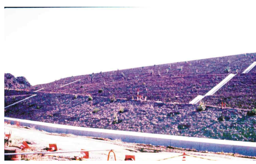
사진 16. 근주 이식공법을 시공한 성토비탈면 전경
