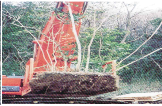
사진 10. 특수장비를 이용한 삼림표토 운반
