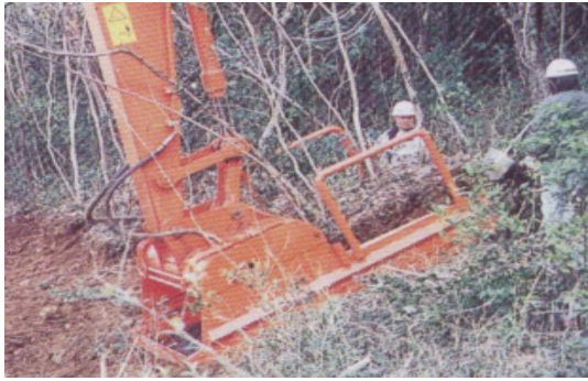
사진 9. 특수장비를 이용한 삼림표토 채취
