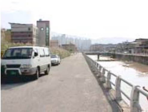
사진 3. 토월천변 남동쪽 가로전경(좌측이 계획대지)
