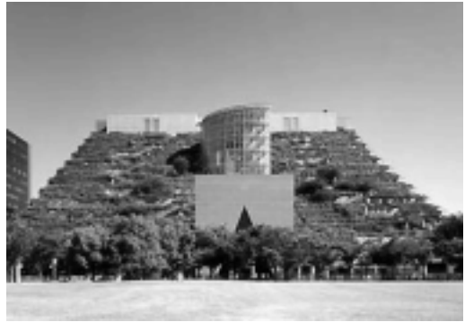
그림 4. 도시에 인공산을 도입한 아크로스후쿠오카 - 건물의 한쪽 면을 식재로 처리하여 도심에 자연을 도입한 사례
