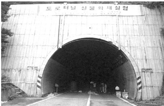
사진 1. 실험 적용 터널 전경
