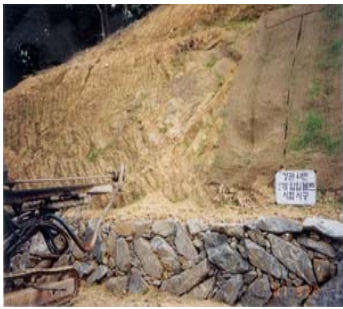
사진 11. 시험 시공 대상지반
