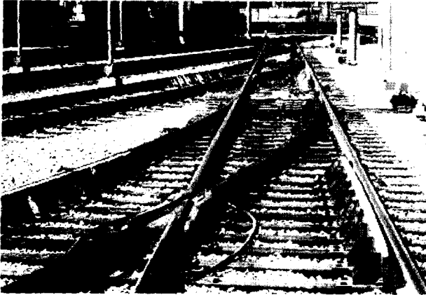
리드곡선반경 190'(57m) 탄성형 스위치레일을 사용한 4.5번 분기기
