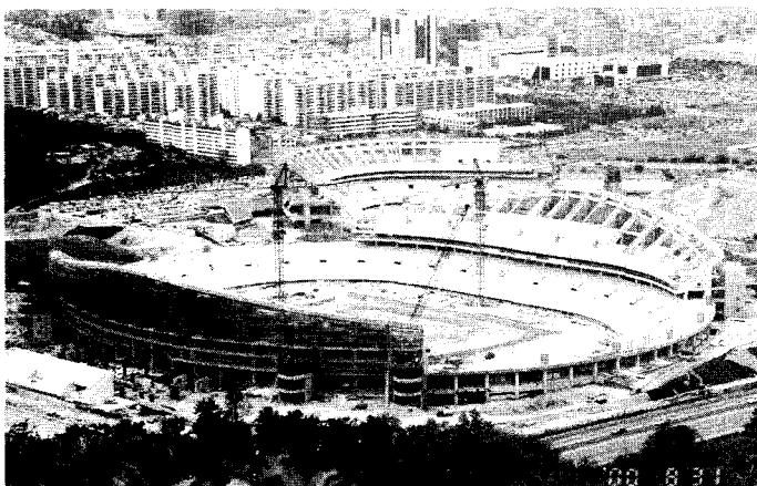
사진 6. 외부 시스템 서포트 설치 전경
