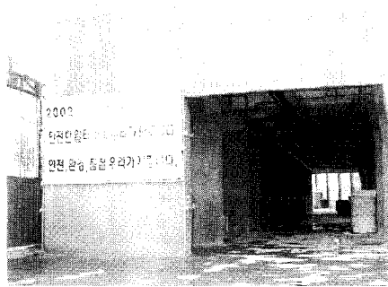
사진 11. 데크층 골조공사 완료(아파트 하부층)
