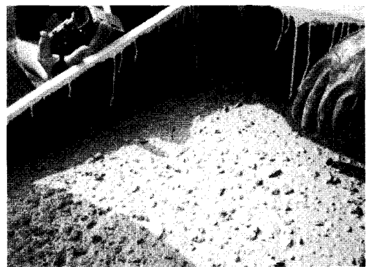
사진 10. 콘크리트 충전 상태
