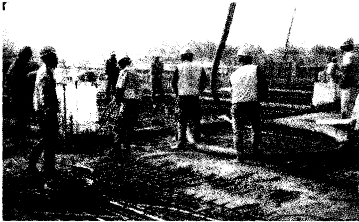
그림 6. 데크 슬래브 콘크리트 타설 모습
