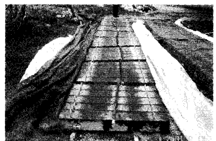
(b) 콘크리트 타설 후 모습
