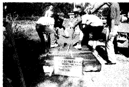
(a) 콘크리트 타설 광경
