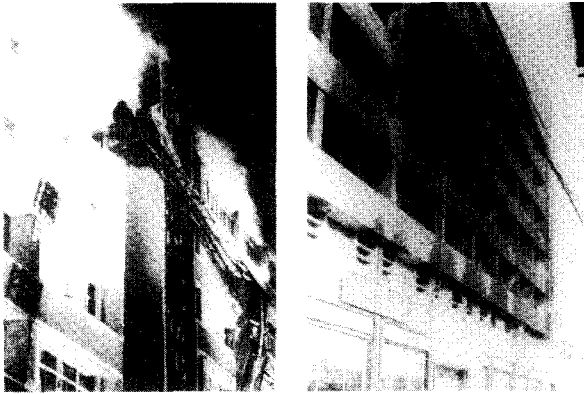
사진 1. 건물 화재 전경
