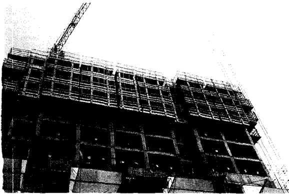
그림 19. Rail Scaffold System
