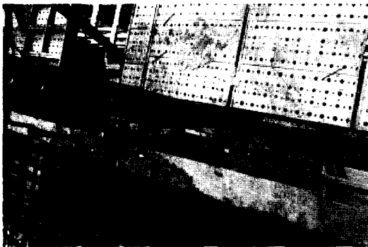
그림 25. Stop-end용 Gang Form
