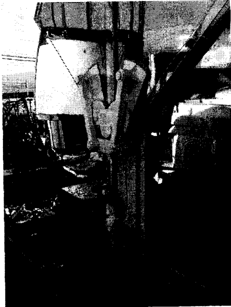
그림 4. 모터와 유압 실린더. 유압 실린더는 뒷편에도 한 조가 더 있어 양쪽에서 모터에 의해 돔 덮개를 밀어 올리도록 구성되어 있다.
