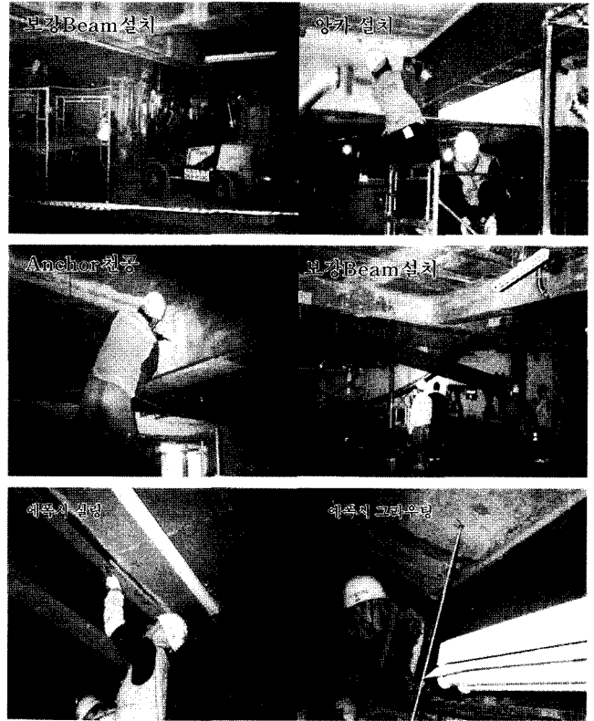
그림 6. 구조물 보강 공사
