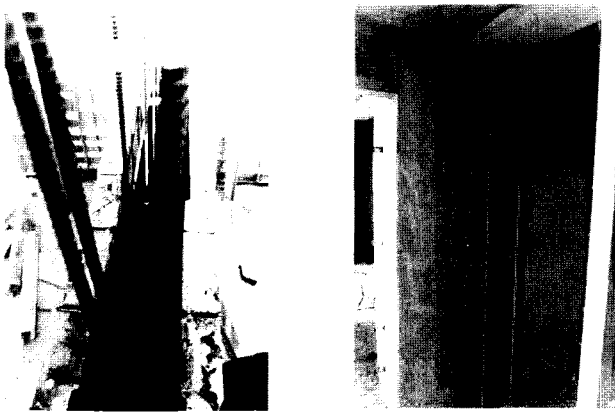
<그림 11>거푸집을 이용한 단열부위 두께 확보
