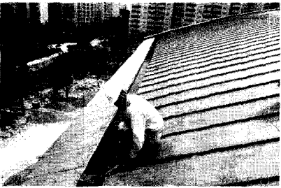
14. GUTTER 부위 담수 TEST
