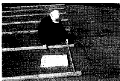
05. 목모시멘트판 + 중도리각재 설치
