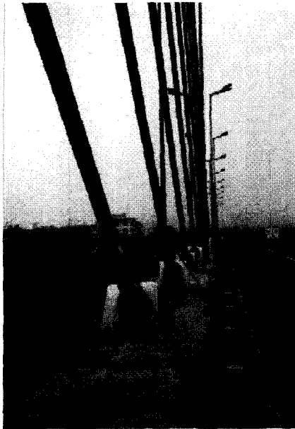
그림 6 Tong ting bridge 실험전경
