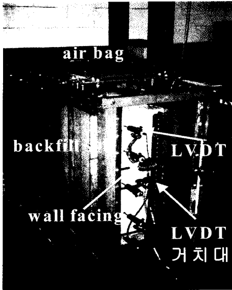
그림 4. 뒤채움 완료 후 옹벽
