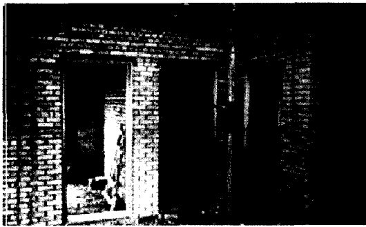
그림 5. 방림동주택 1층 IN PROGRESS
