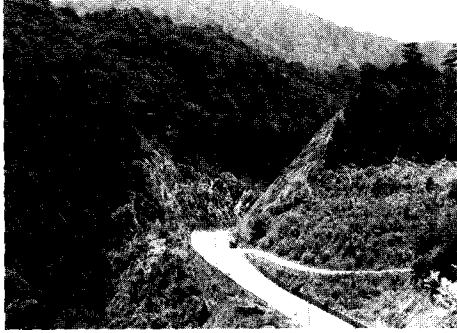
사진 15. 도로에 의한 생태계 단절(도래기재, 414번 국도)
