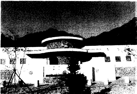
[그림 10] 화암동굴 화장실 외관
