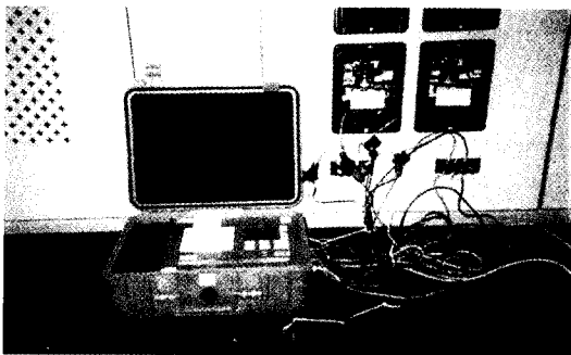
사진 1. 수전점에서의 고조파 측정 장면
