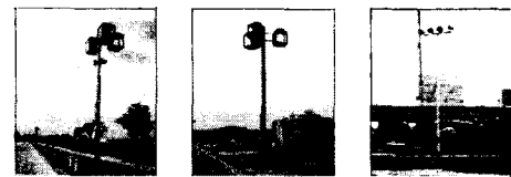
사진 3. 보치운동도로등 사진 4. 공원보행도로등 사진 5. 주차장등
