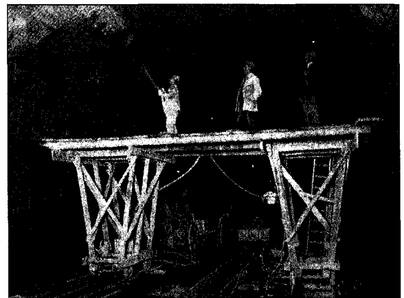
그림 12. 스위스 쥘리히 Ulmberg 터널에서의 숏크리팅(1927)
