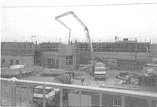
[사진 9] 2층 부어넣기 모습
