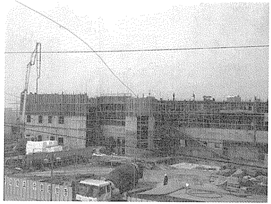
[사진 10] 3층 부어넣기 모습
