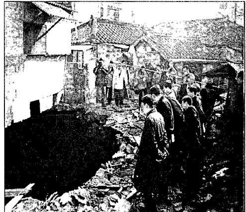
〈그림 - 7〉 지하수 과다채수로 인한 지반침하현장 (전남 무안읍)
