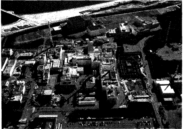
일본의 도카이에 있는 재처리 시설. 일본은 우라늄 자원 절약과 효율적 활용을 목적으로 재처리 후 회수된 우라늄과 플루토늄을 고속중성로의 연료와 발전용 원자로의 혼합 핵연료로 재순환시키는 「핵연료 재활용 정책」을 채택하고 있다.
