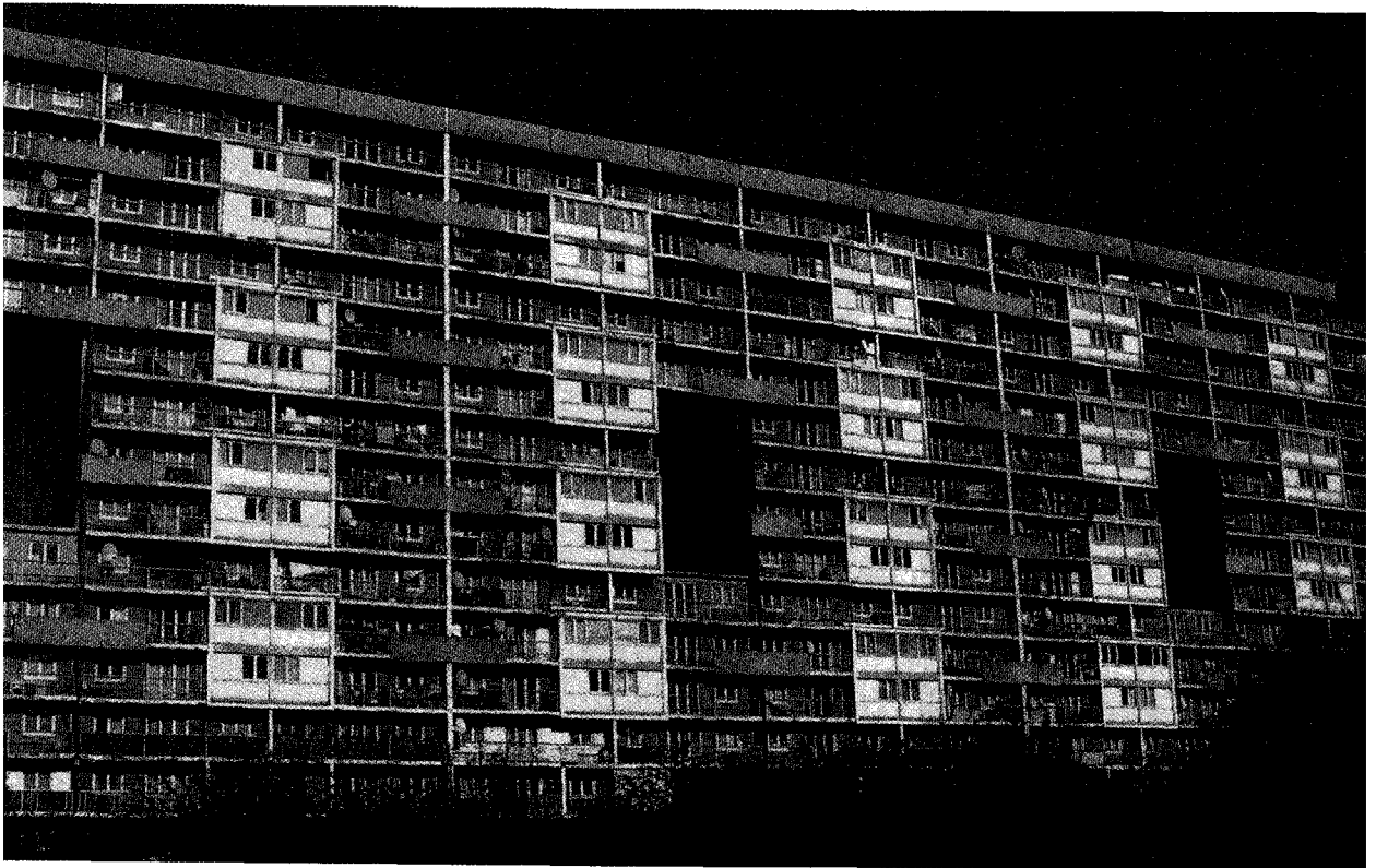
남쪽에서 본 외관. 건물의 동서방향의 길이는 약 180m이다. “장벽”의 일부를 제거하여 압박감을 완화시켰다. 당초에는 다섯군데를 제거하자는 의견도 있었으나 주거용으로 전환시킬 가구수가 맞지 않아서 재고했다.
