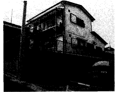
콘크리트블록만으로 높게 쌓아올린 옹벽으로 조성되어있다. 이곳에서도 건물이 기울어져 있었다.
