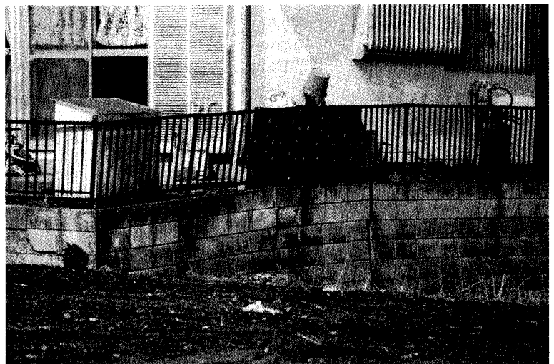
조성된 부지가 침하했다.콘크리트 블록으로 방토(防土)되어 있지만 블록의 벽면에 커다란 용열이 생겼다.
