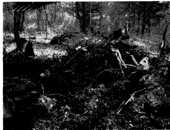
조성할 때 벌목된 나무나 잡초 등이 그대로 부지 속에 매립되어 있는 경우도 있기 때문에 주의가 필요하다.
