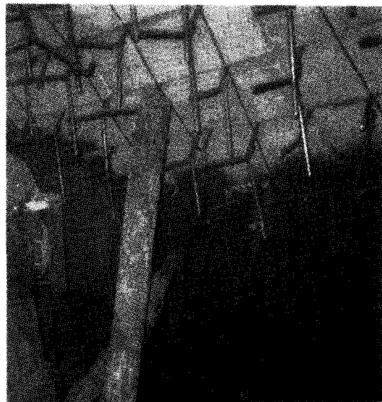
〈Fig. 16〉 Cooler tertiary 부위(좌)와 천정부 SHOTCAST 시공(우)
