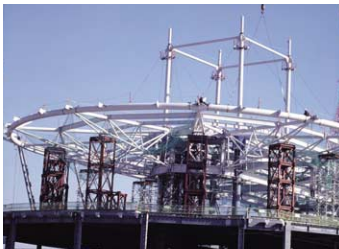
〈표지사진〉 파고다 엔드트러스 설치공사: 인천국제공항 여객터미널 지붕중 콘코스 부분
