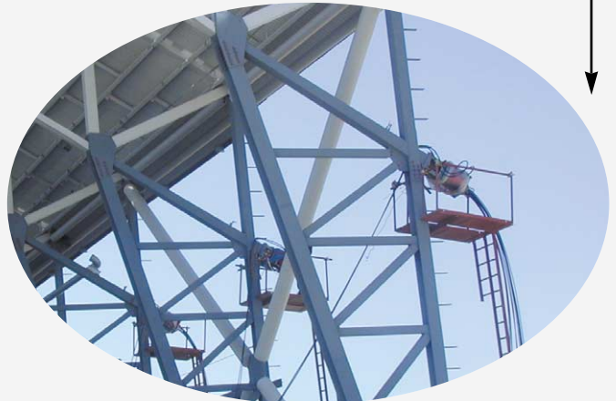
인발 JACK 설치부분 Crose up 사진
