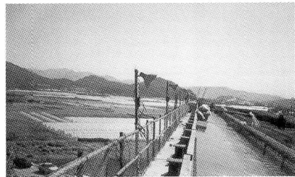
[사진 4] 교량안전난간 설치에
