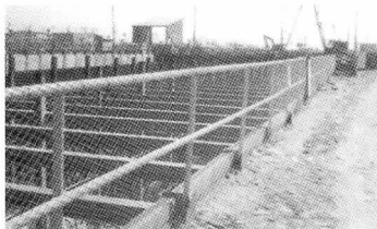
[사진 2] 흙막이공 단부 안전난간 설치에
