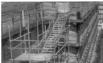
[사진 1] 흙막이 경사로 및 단부 안전난간 설치에
