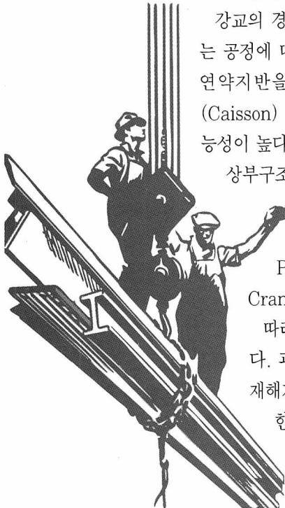
상부구조의 가설에 있어서는 고소작업이 주체가 되므로 추락재해가 대단히 많다. P.C교에 있어 현장 타설방식의 경우 대규모 거푸집 및 동바리가 쓰이므로 동바리의 도괴재해가 문제가 되고, Precast Beam을 가설할 때는 대형의 양중기를 사용하므로 Crane · Derrick 및 관계 설비에 의한 재해가 많다.
