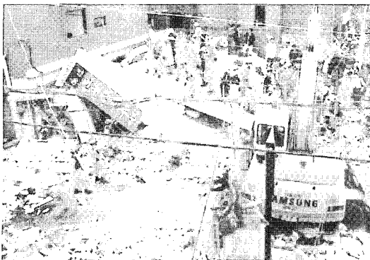
사진 1. 사고현장의 붕괴된 모습
