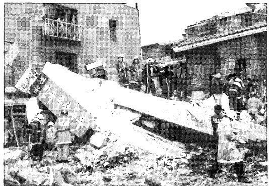
사진 2. 붕괴현장 및 매몰자 구조작업 모습
