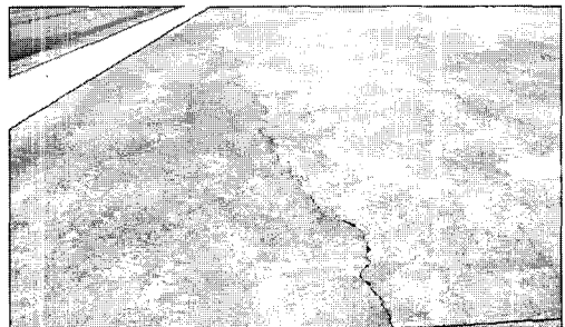
사진 4. 균열-콘크리트 포장
