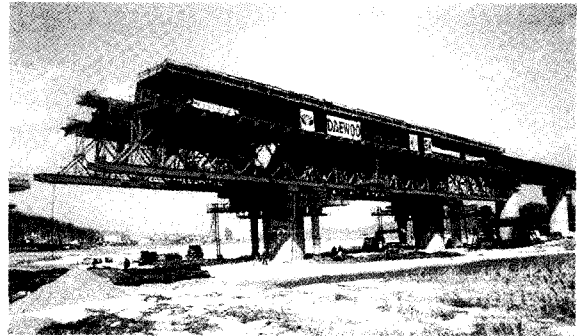
사진 9 신공법 MSS 장비 이동
