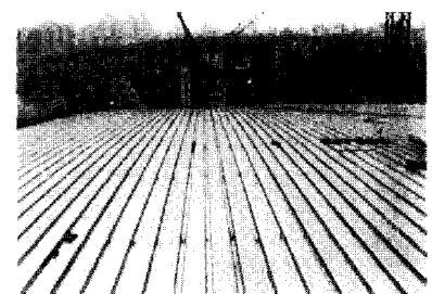
사진 10. Metal Deck설치
