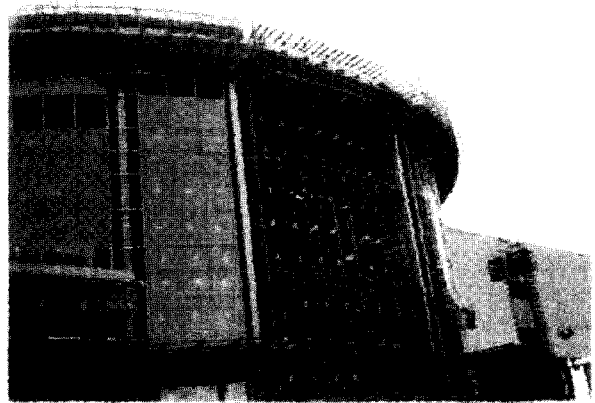
사진 15. Glass Fin 설치
