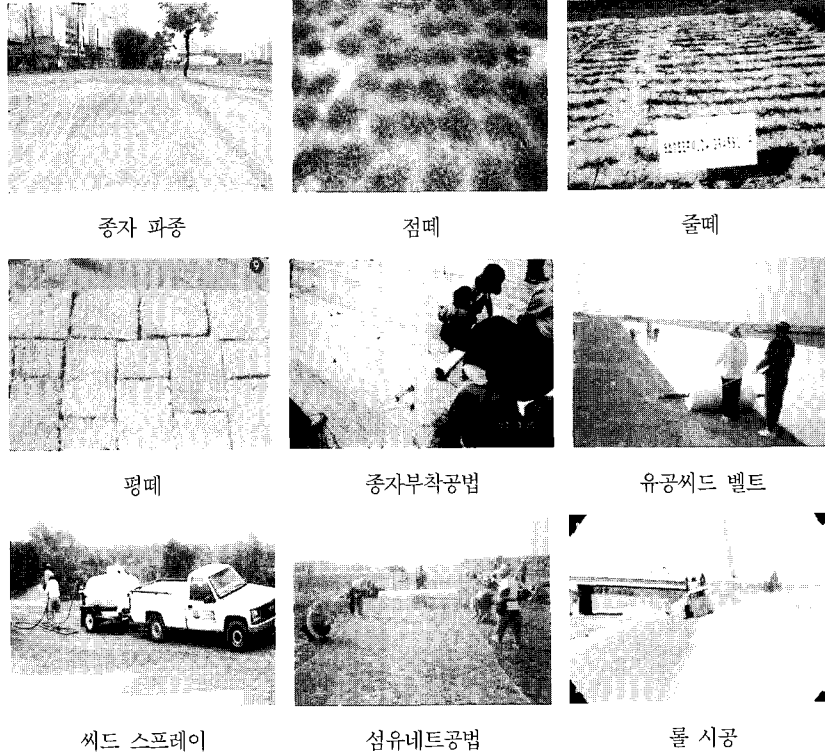
그림 3. 각종 잔디 시공 기술
