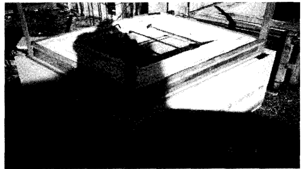
사진 4. Slab 시험체 거푸집 (양생상옥 설치 전)
