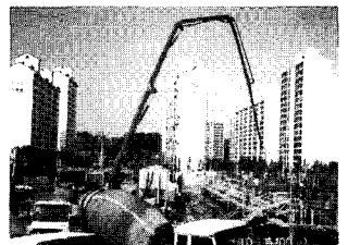
사진 10. 콘크리트 부어넣기
