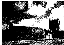
그림 5-1. Overall view of northwest facade
