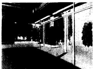
<그림 17> 주택의 경량 철골 프레임에 매달린 얇은 유리커튼월을 보여주는 렌더링
